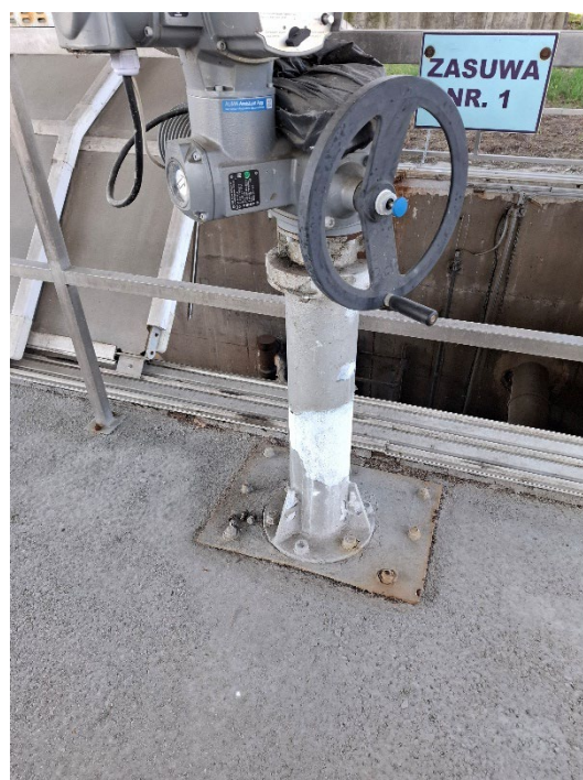
Foto nr 14 podstawy stalowe pod zaworami AUMA
