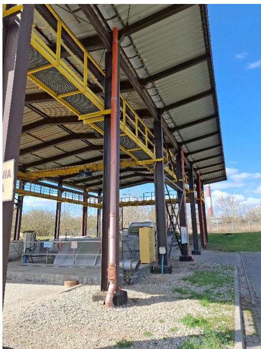
Foto nr 5 widok rury spustowej
